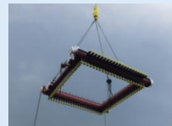
ボイラの管寄せ部
