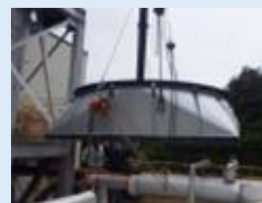
焼却炉の復旧作業の様子
