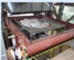
焼却炉とボイラ上部の接合部
