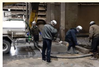
吸引した油をビットへ投入する様子
