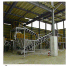
11 スラグ製砂設備棟
