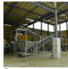
11 スラグ製砂設備棟
