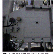
9 白煙低減用排ガス加熱器
